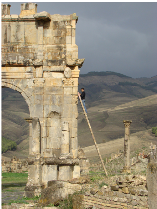
Installation d'un capteur de mesure de la température et de l'humidité de la surface de la pierre sur l'arc de Caracalla, Cuicul (Algérie)
