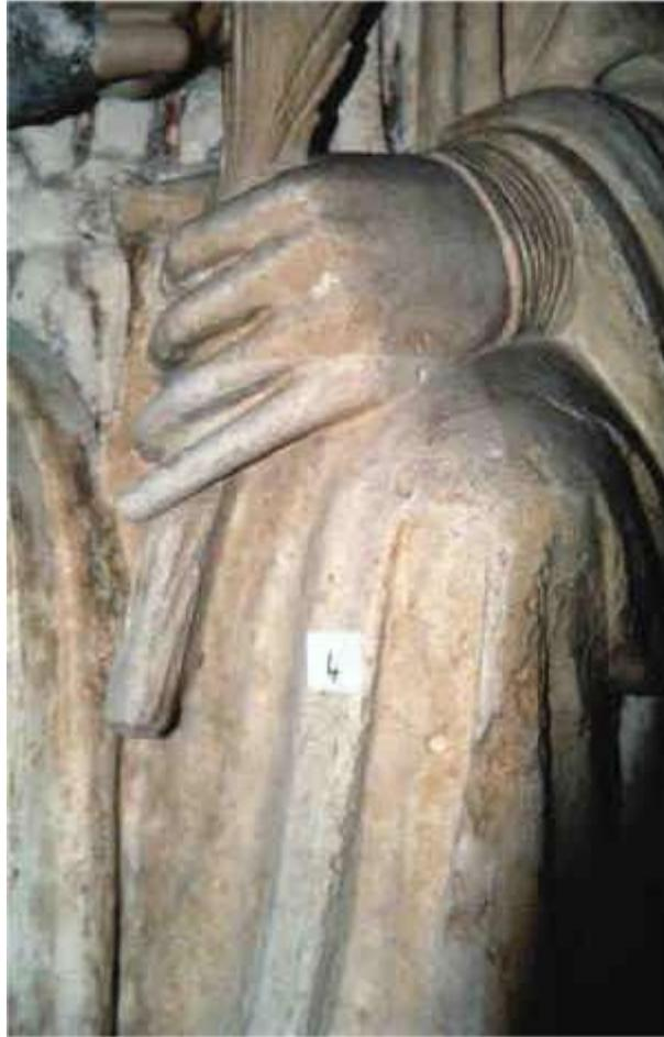
*Photo 3 : atténuation de la teinte jaune, après nettoyage laser, par application de compresses d'eau dans la partie basse de l'image, restauration du portail central de la façade ouest de la cathédrale Notre Dame de Paris (photo M Labouré).*
