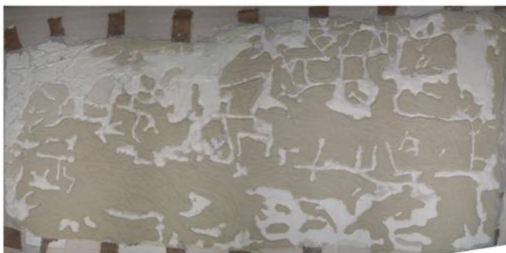
Opération de dessalement par le revers (cl. SINOPIA). Cette opération a été basée sur des travaux récents menés en particulier dans le cadre du programme européen « Desalination of Porous Building Materials » (2006-2010). Le traitement différent des fissures, visible ici, avait pour but de limiter la migration des sels dans la couche picturale et de favoriser celle-ci dans la compresse de dessalement
