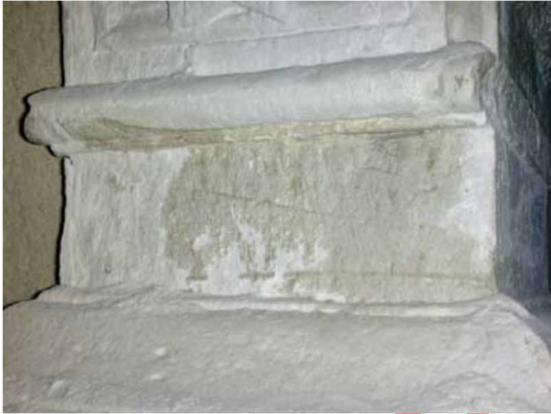
Figure 3 : désagrégation granulaire du marbre sur le sommier d'un arc avec conservation partielle de la couche brunâtre translucide (craie).
