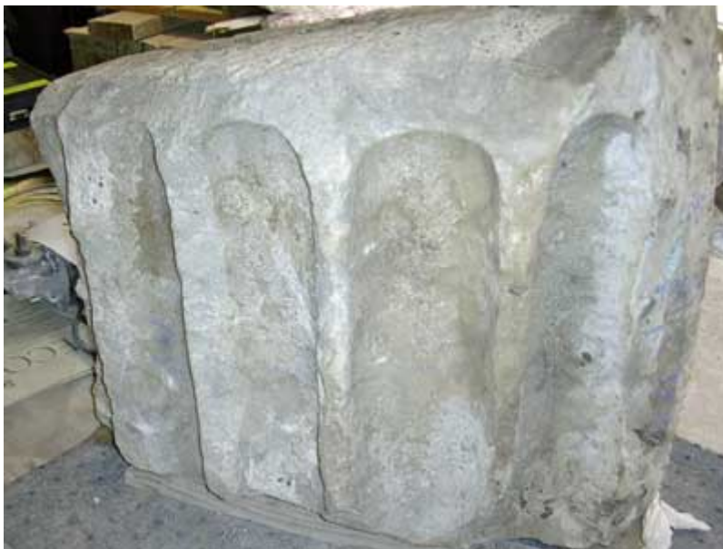
Figure 2 : vue du revers de l'un des deux claveaux déposés sur la lunette droite, présentant les moulures d'une colonne probablement antique.
