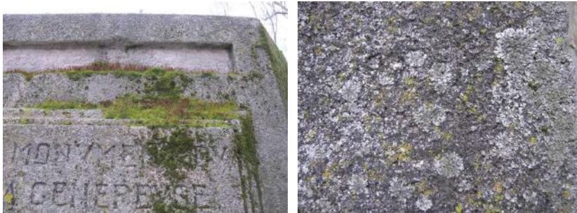
**Pulvéulence** : décomposition d'un matériau à l'état de poudre observée à la surface de la pierre. Cette altération est souvent liée à l'eau (infiltration, ruissellement) et s'accompagne fréquemment de soulèvement de matière (cloques, desquamations, délitement).
