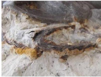
**Joints lacunaires** : l'espace entre des éléments de pierre joints présente une perte de matière conséquente, produite par l'exposition aux pluies, à l'érosion, le manque d'entretien ou un dégât mécanique. Les lacunes de joints sensibilisent l'édifice à l'infiltration d'eau.
