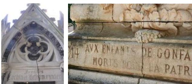
**Fracture** : résultat d'une fissure en profondeur qui sépare en deux parties un bloc de pierre.
