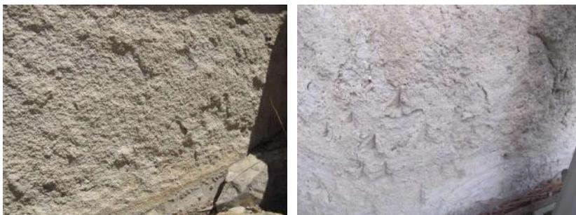
**Efflorescence saline / auréole** : formation de cristaux blancs d'aspect poudreux apparaissant à la surface de la pierre et constitués de sels solubles. L'efflorescence résulte du transfert de l'eau dans les pores de la pierre puis de l'évaporation superficielle de l'eau chargée de sels minéraux.
