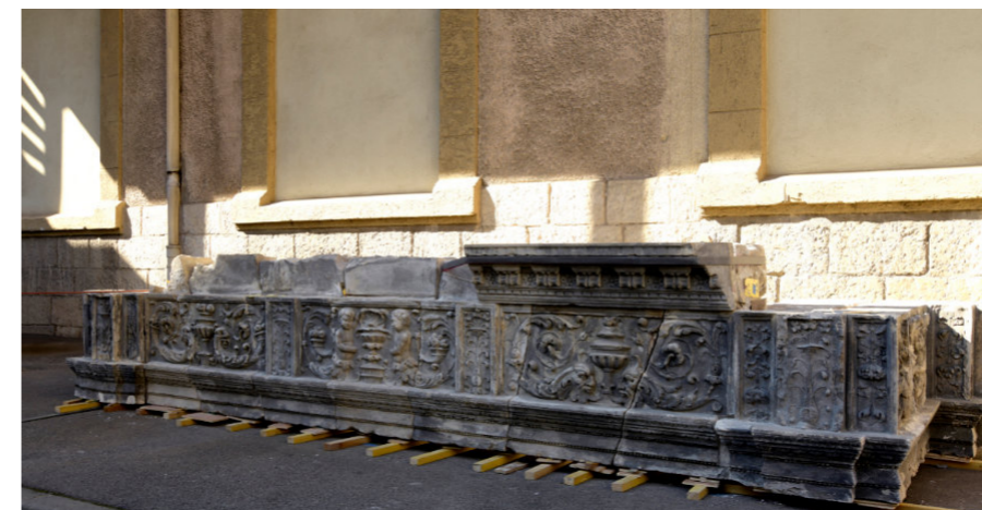
Cheminée du château du Bosquet : remontage à blanc du linteau dans la cour du CICRP, en vue du remontage dans la grande salle du château. Photo : CICRP - O. Guillon.
