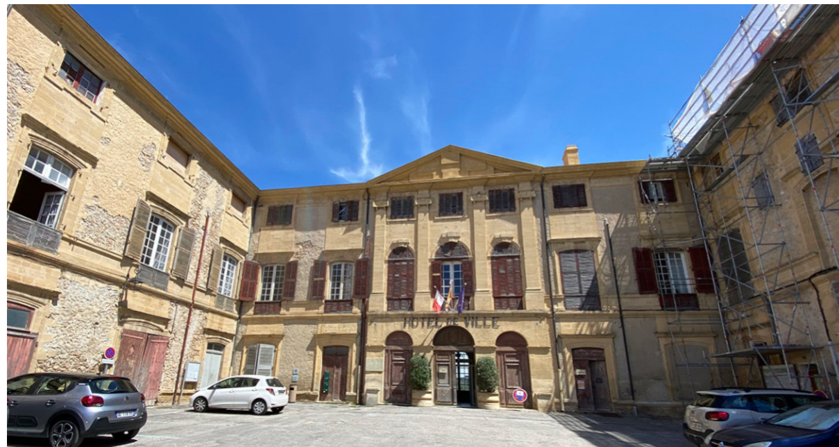
Ancien château de Peyrolles-en-Provence, aujourd'hui hôtel de ville : façades sur cour. Photo : CICRP - P. Bromblet.
