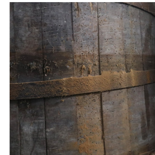
Réserves du musée du Bocage normand, Saint-Lô : détail des dégradations sur une cuve. Photo : CICRP - F. Fohrer.
