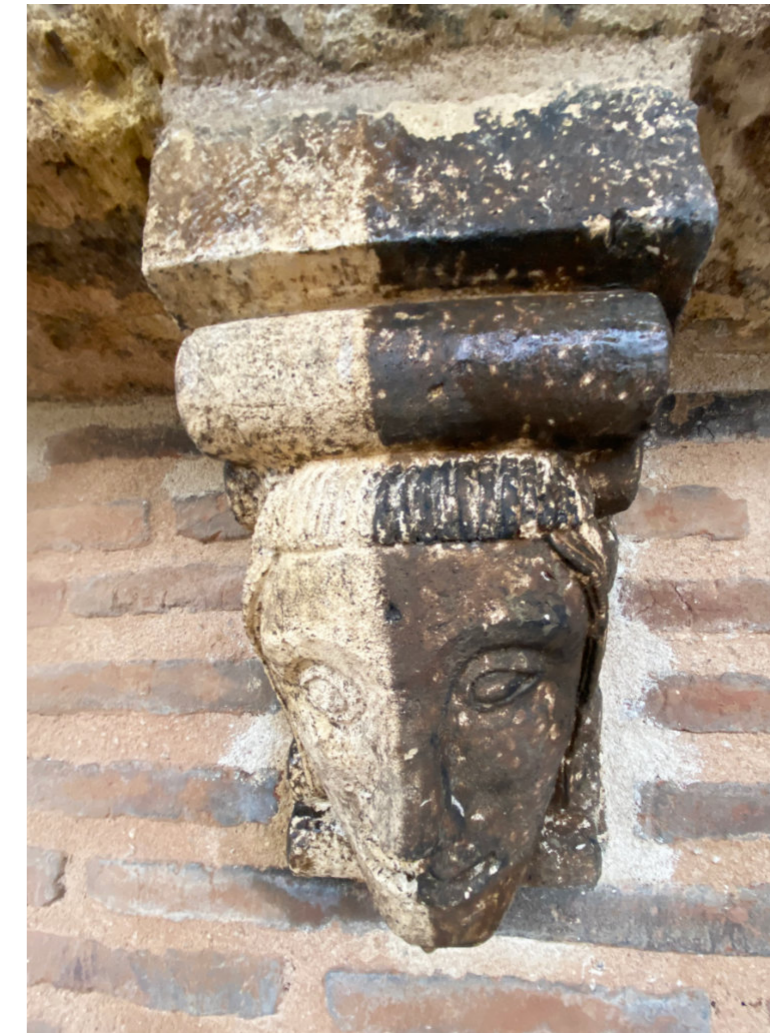
Basilique Saint-Sernin, Toulouse : test de nettoyage sur un modillon de la façade occidentale. Photo : CICRP - P. Bromblet.
