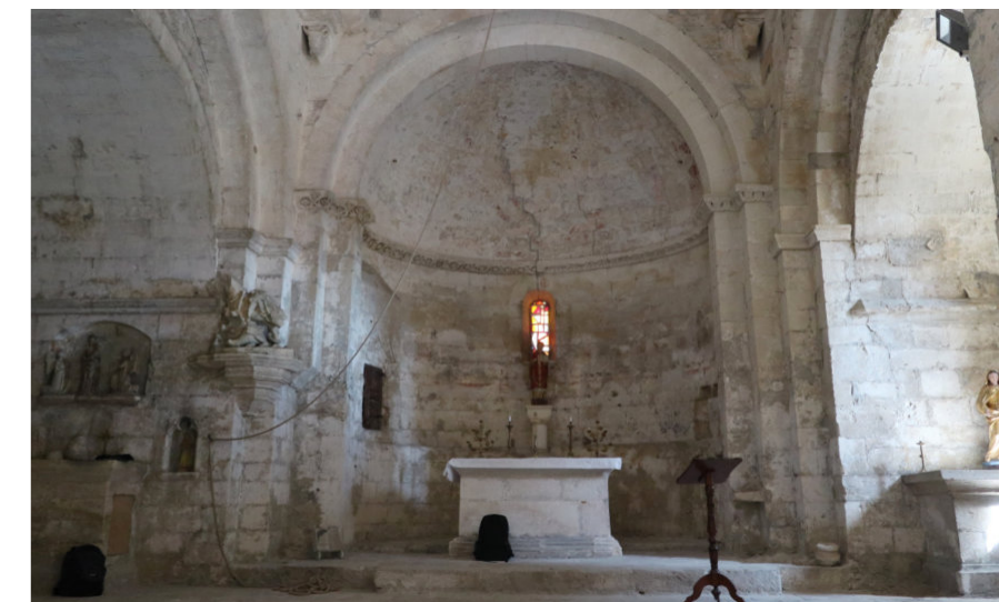
Chapelle Saint-Marcelin de Boulbon : vue intérieure. Photo : CICRP - P. Bromblet.
