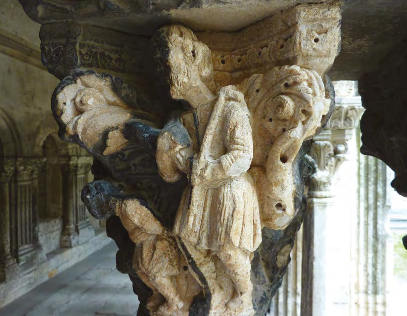
Cloître Saint-Trophime, Arles : élimination en cours par nettoyage laser de la croûte noire sur un chapiteau en marbre blanc.
