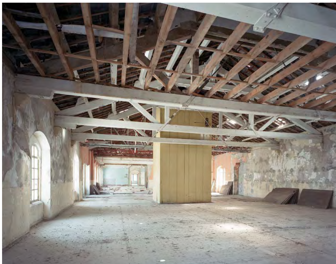
La salle des grands formats (ateliers), avant travaux
