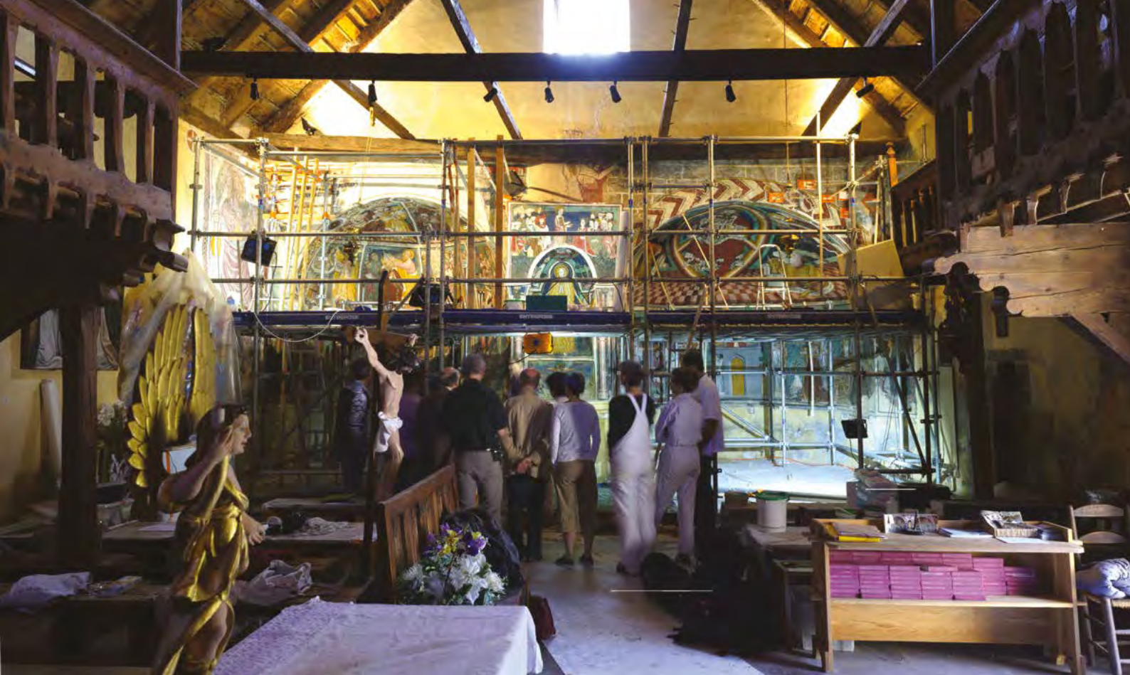
Chapelle Saint-Erige, Auron-sur-Tinée : réunion de chantier pour la restauration des peintures murales, en présence de l'équipe en charge de l'étude.
