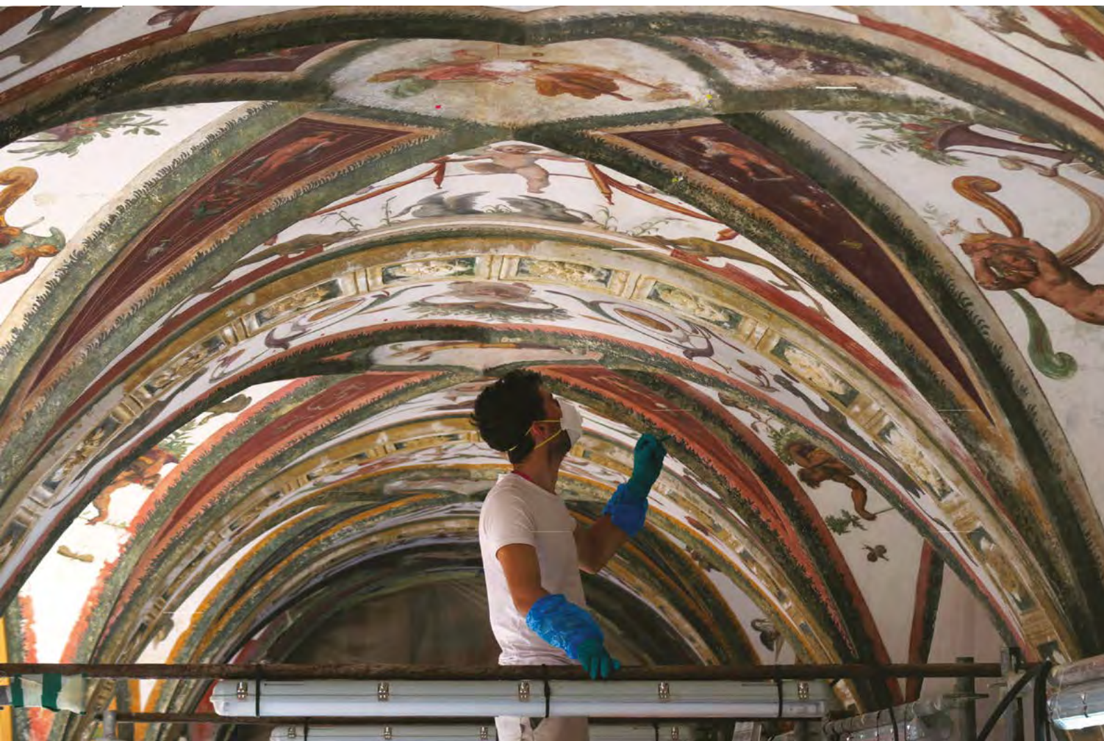
Palais Princier, Monaco : dégagement mécanique et nettoyage des voûtes de la galerie d'Hercule.
