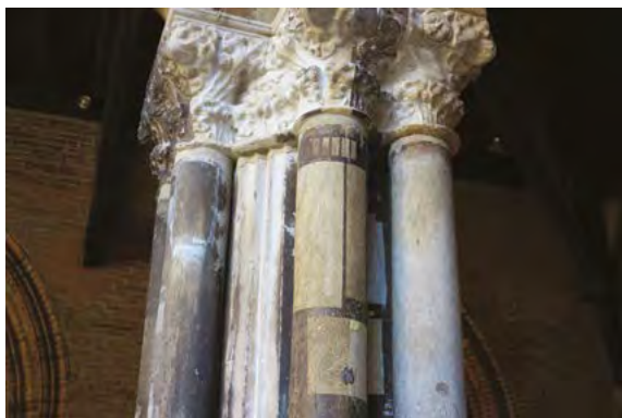
Tests de nettoyage réalisés par l'atelier Bouvier dans le cadre de l'étude préalable à la restauration du cloître.
