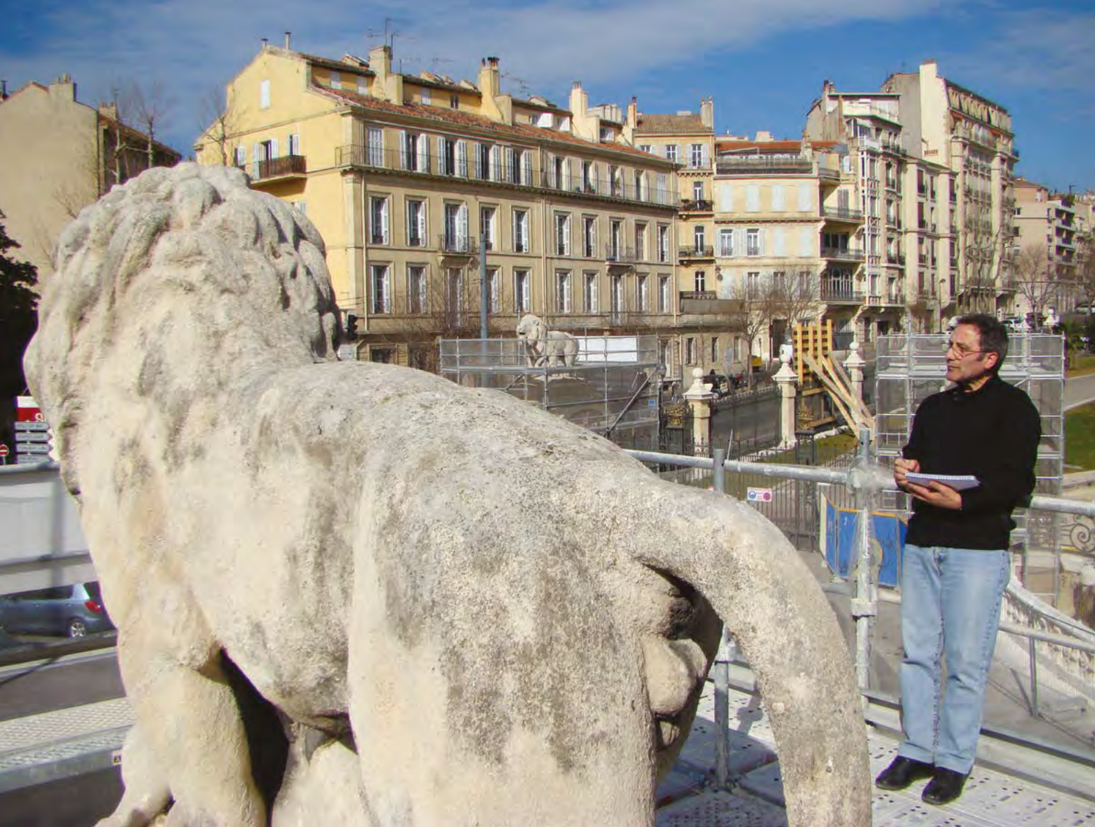
Portail d'entrée du palais Longchamp, Marseille : examen par Vincent Mercurio de l'état de conservation d'une sculpture de Barye (1795-1875) en pierre de Calissanne.
