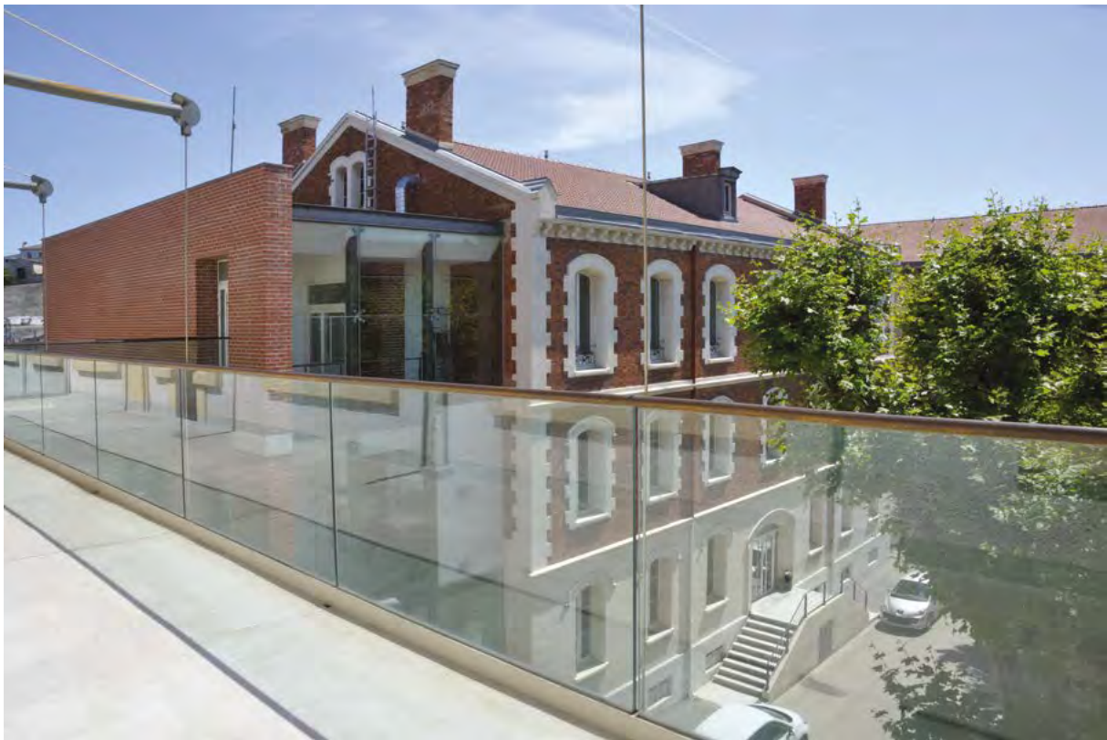
Le bâtiment administratif depuis la coursive du second étage des ateliers.
