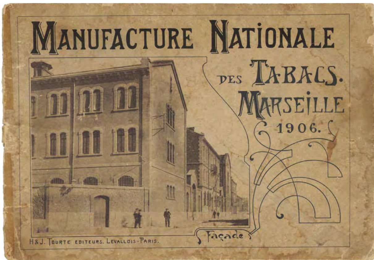
La Manufacture des tabacs, édifée de 1862 à 1868 rue Guibal, à proximité de la gare Saint-Charles (page de couverture de l'album [MH, D 98.3.9]).
