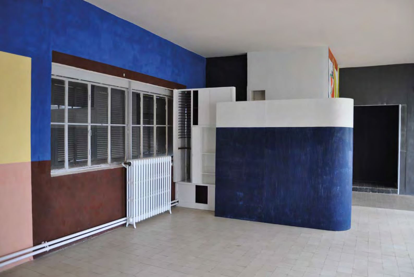
Eileen Gray, Jean Badovici, Villa E-1027, 1929, Roquebrune-Cap-Martin : reconstitution des polychromies intérieures suite aux études et travaux de restauration menés par l'agence Pierre-Antoine Gatier.
