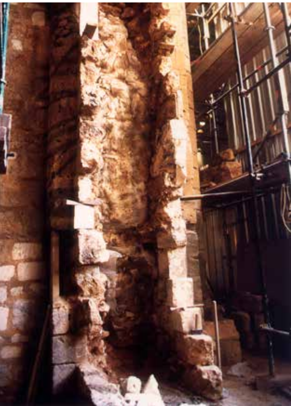
(fig. 2) Suppression du blocage interne des murs.
