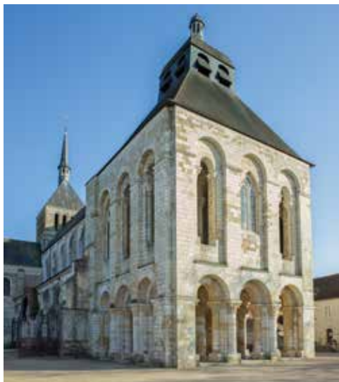
(fig. 4) Vue d'ensemble de la tour-porche après travaux.
