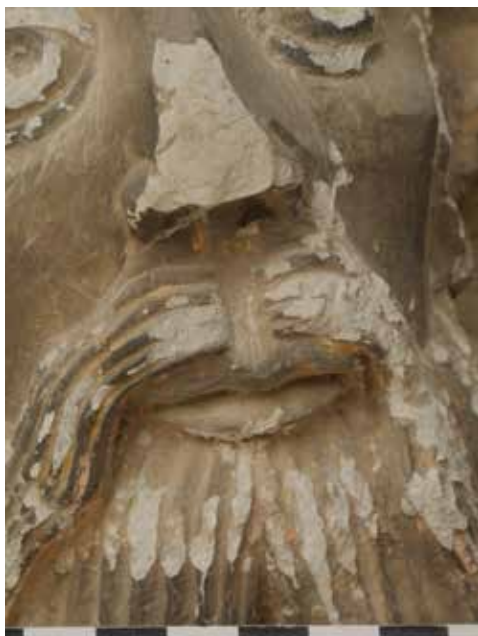
(fig. 7) Détail : pertes dues aux sels sur les parties en saillie. On observe le même type de pertes en bas du tympan sur les orteils des vieillards. Leur aspect propre montre qu'elles ne sont pas très anciennes.
