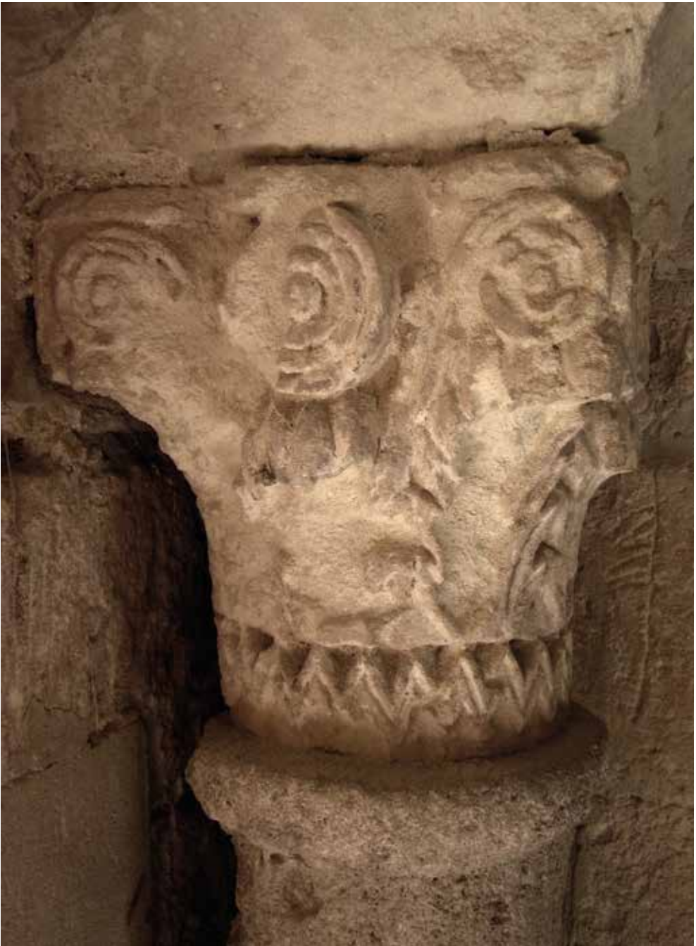
(fig. 1) Chapiteau roman en cours de désagrégation saline, avant démontage et dessalement, ermitage Saint-Pierre, ancienne abbaye de Montmajour [Arles].
