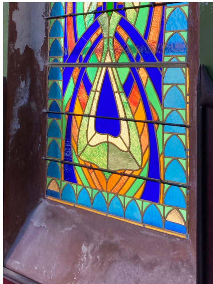
Villa Laurens, Agde : altération des décors peints dans l'encadrement des vitraux du salon de musique. Photo : CICRP - P. Bromblet.
