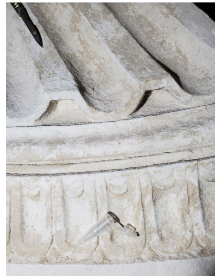
Le bloc L2 de la chapelle, sur lequel des prélèvements ont été réalisés pour caractérisation de la couche brune.
