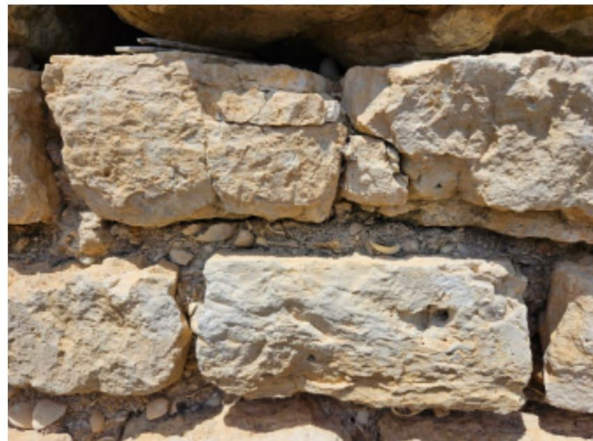
Vue de détail d'un mortier à la chaux chargé de fragments d'organismes marins (coquilles de mollusques, exosquelettes de bryozoaires et de coraux) sur un mur du site archéologique de Saint-Martin-le-Bas à Gruissan.
