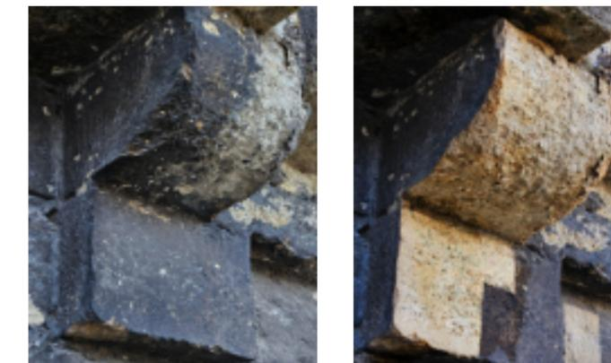
*Avignon, remparts : prises de vues réalisées avant et après les essais de nettoyage laser sur un corbeau du mâchicoulis, au niveau de la porte de la République.*
