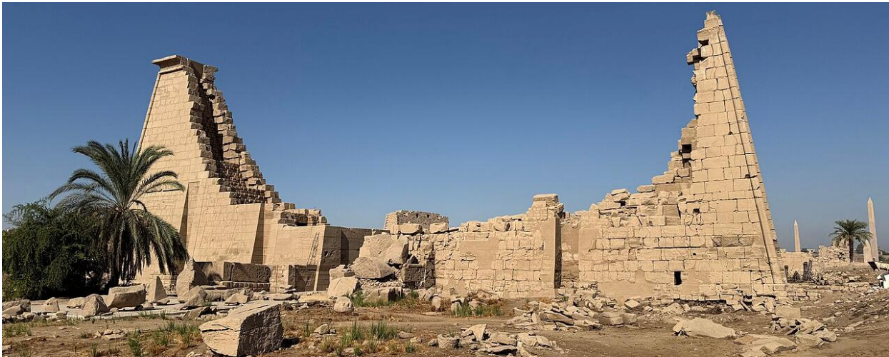
Fig.1. 9eme pylône de Karnak
